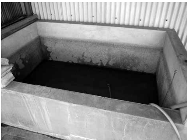
写真6 コンクリート製の水槽で糊落とし
